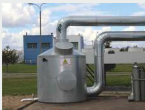
Filtr siloksanów w Łodzi 1300 Nm 3 /h
