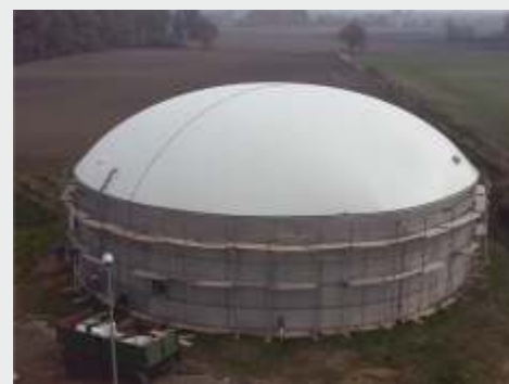
Zbiornik biogazu w Sieńsku 26 m średnicy
