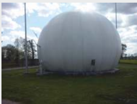
Zbiornik biogazu w Drzycimiu 570 m 3 pojemności
