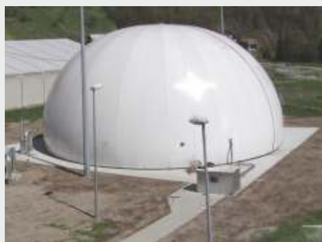
Zbiornik biogazu w Tymbarku 1500 m 3 pojemności
