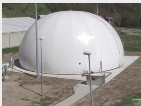
Zbiornik biogazu w Tymbarku 1500 m 3 pojemności
