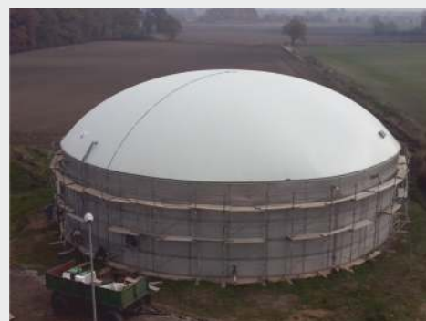
Zbiornik biogazu w Sieńsku 26 m średnicy
